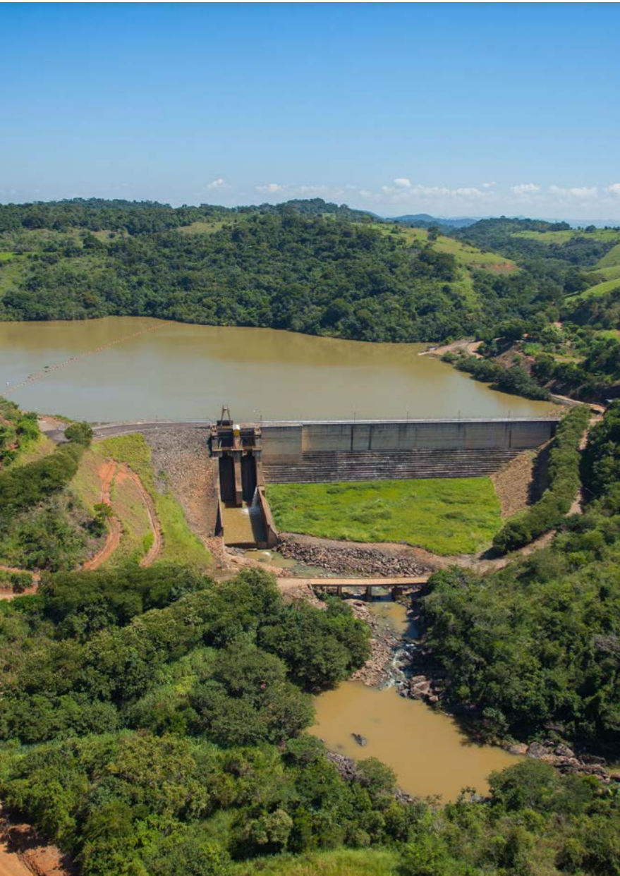
Hidroeléctrica Ivan Botelho I
